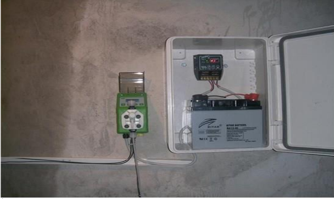
İçme suyu depoları 24 saat otomatik klorlama cihazları ile dezenfekte olunmaktadır.
